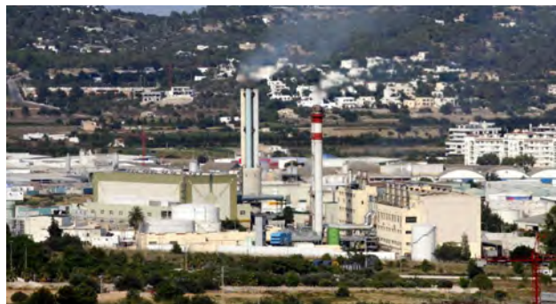
Central térmica GESA
